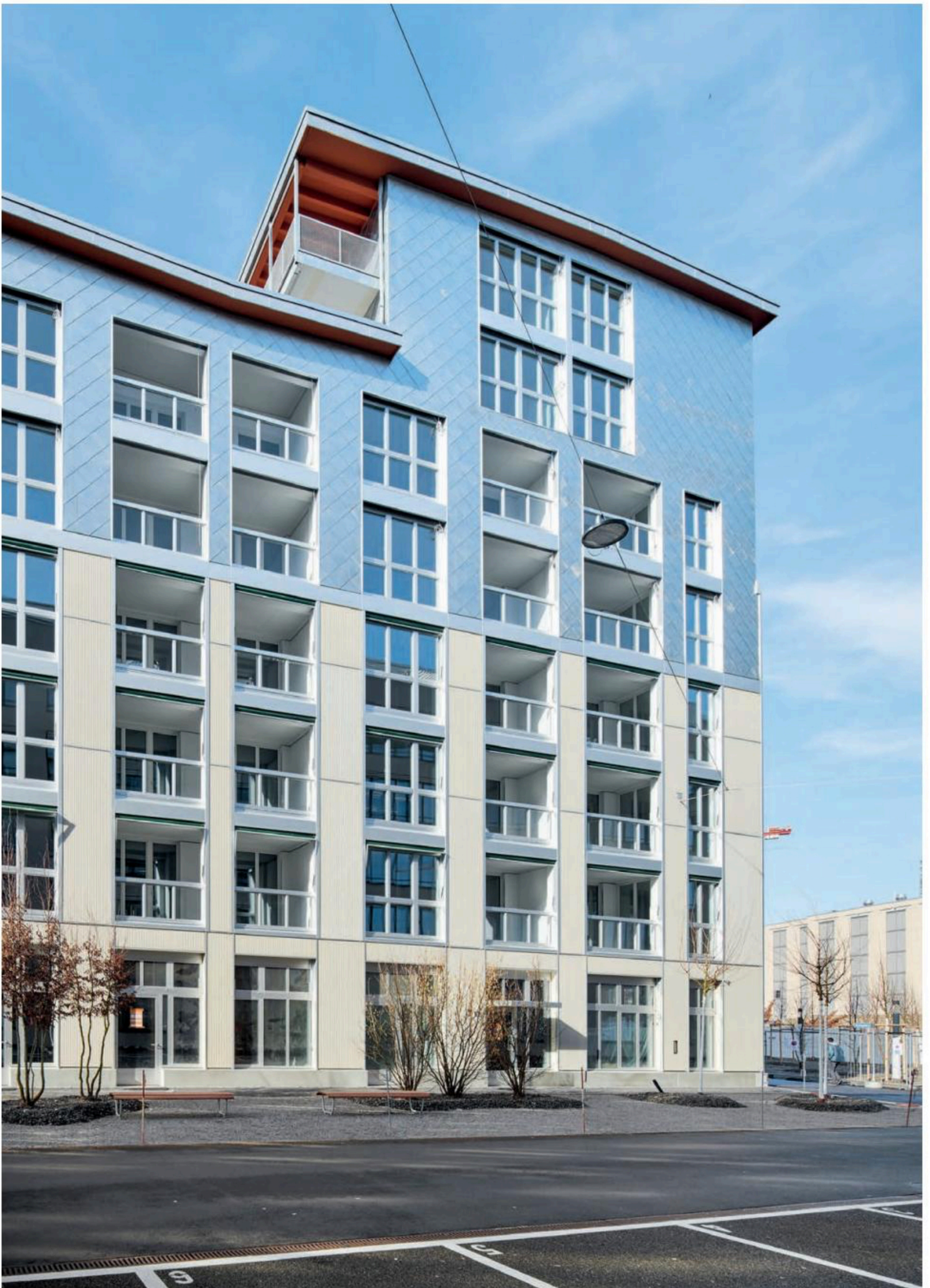
Die Fassade der Überbauung «Krokodil» auf dem Sulzer-Areal in Winterthur gibt sich industriell. Der Dachvorsprung verweist orange leuchtend auf die Holzkonstruktion.
